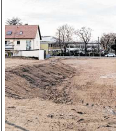
Die Baustelle für den evangelischen Kindergarten Leutershausen. BILD: SCHILLING
