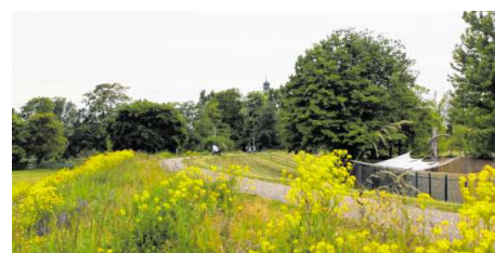
Der Hochwasserdamm in Ilvesheim.
